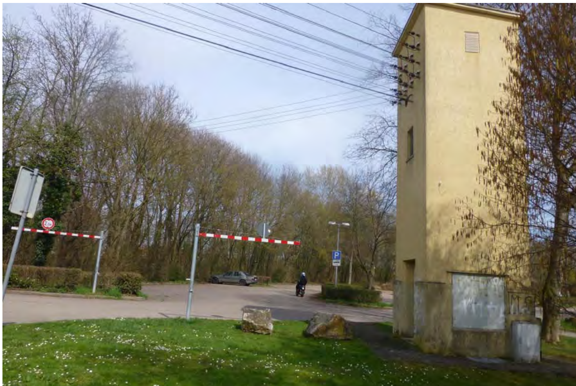
Abb. 2: Umspannhäuschen und Parkierungsflächen
