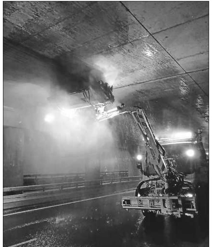
Die Arbeiten umfassen bei allen Tunneln die Reinigung der Tunneldecke und der Tunnelwände mit einer Spezialmaschine, die Reinigung der Entwässerungsanlagen und die Wartung der Beleuchtungsanlagen sowie der technischen Einrichtungen.
